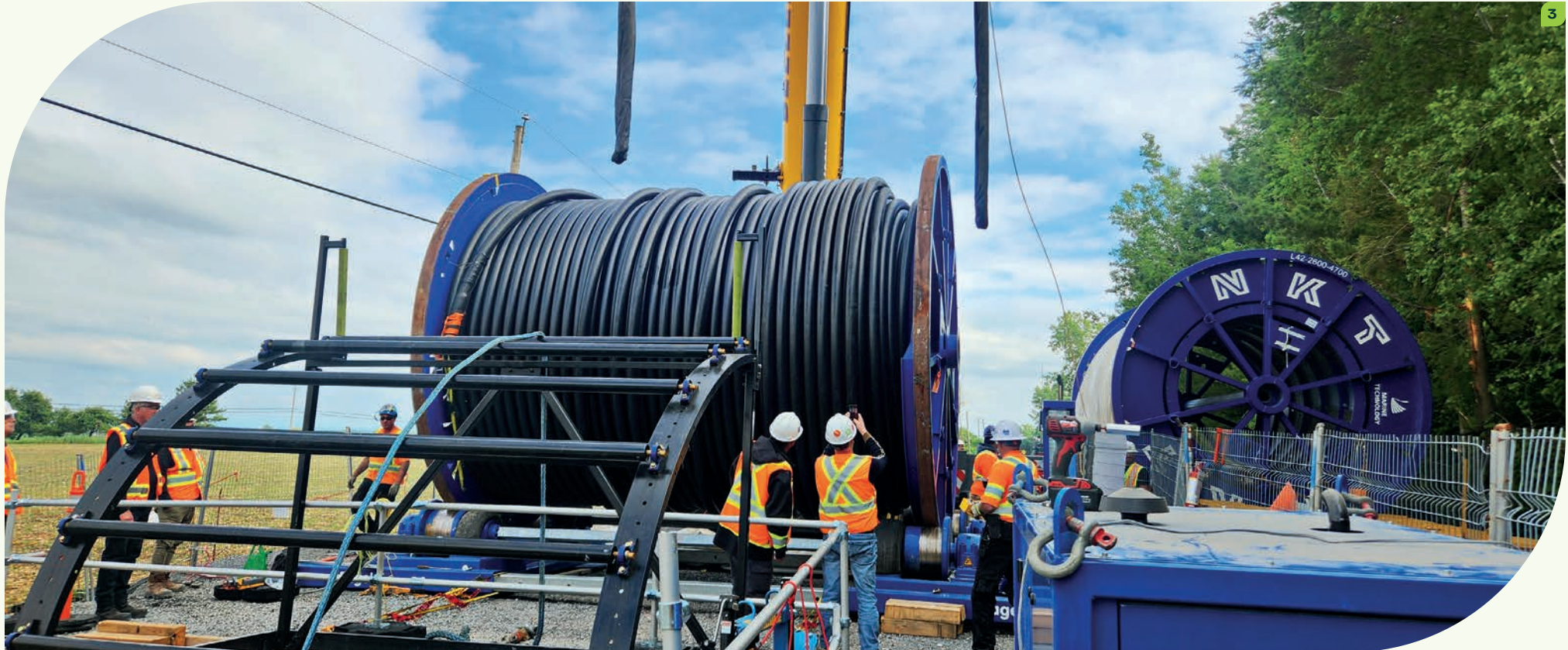
3 Déroulage d'un câble à travers une baie souterraine
