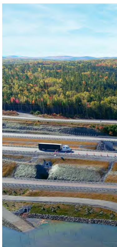
Grands Prix 2023 Infrastructures de transport Construction de l'autoroute 85, St-Antonin Norda Stelo
