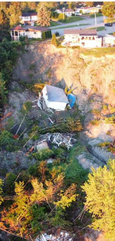
Grands Prix 2023 Géotechnique et ingénierie des matériaux Glissement de terrain et restauration de talus | Englobe
