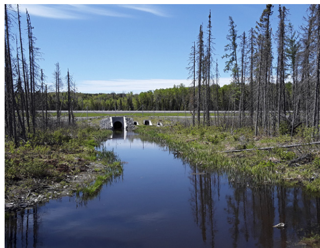
Ponceau à refoulement pour recréer l'habitat d'origine et permettre le passage du poisson.
