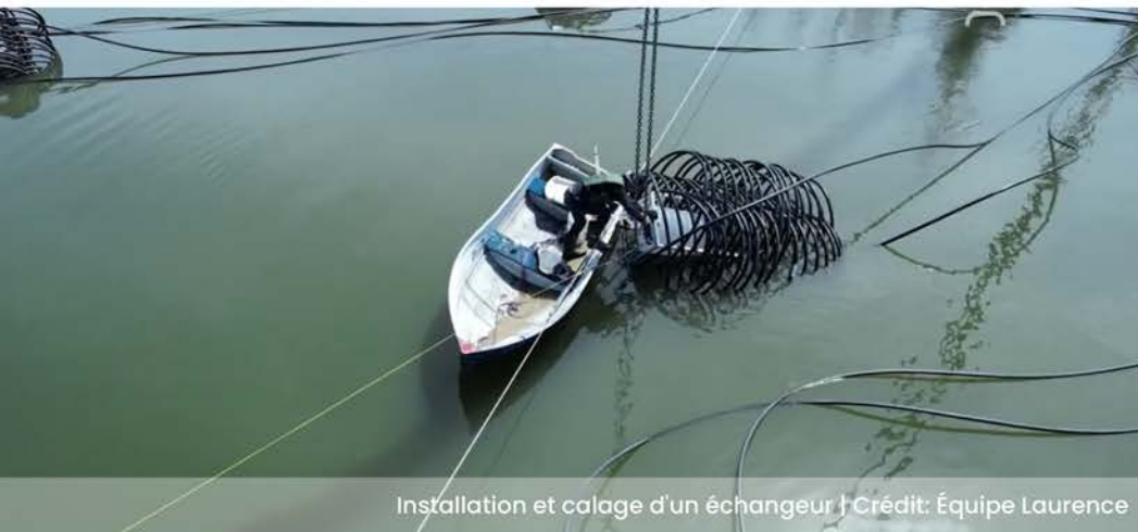
Échangeur durant installation | Crédit: Équipe Laurence
