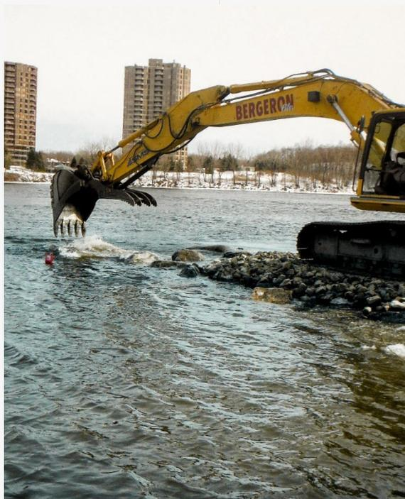
Construction de la digue avec des roches granitiques, naturelles et propres de 1000 à 1360 mm de diamètre
