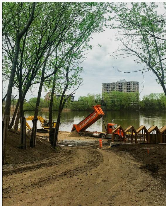
Mise en place du sable sur la rive à l'aide d'un batardeau temporaire en bloc de béton
