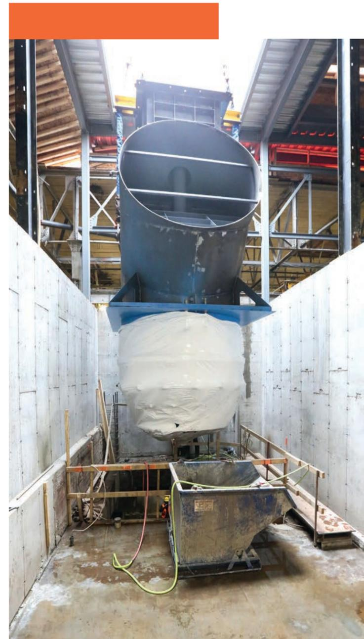
Une nouvelle turbine verticale positionnée à l'aide d'une grue
