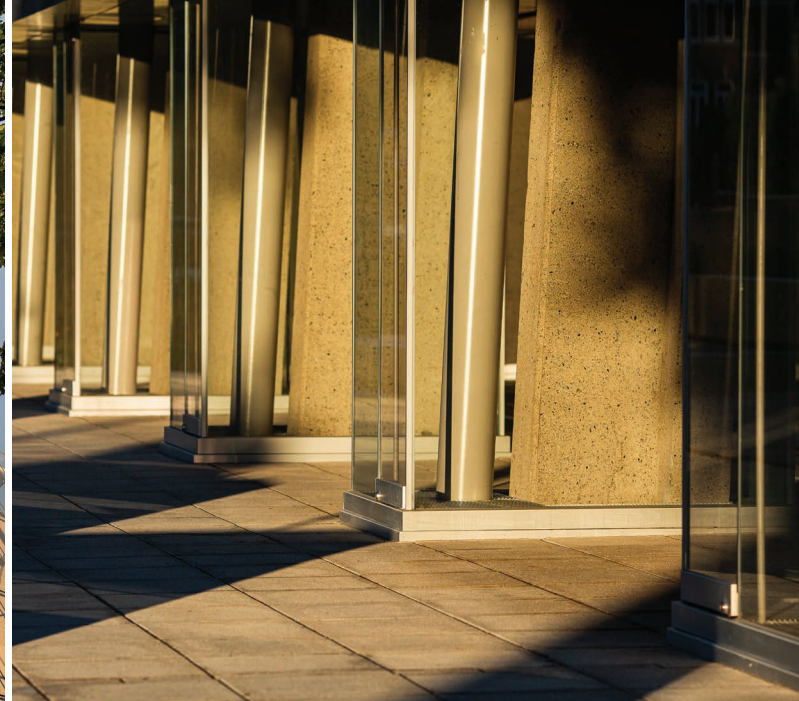
Colonne isolée Photo : Jonathan Robert
