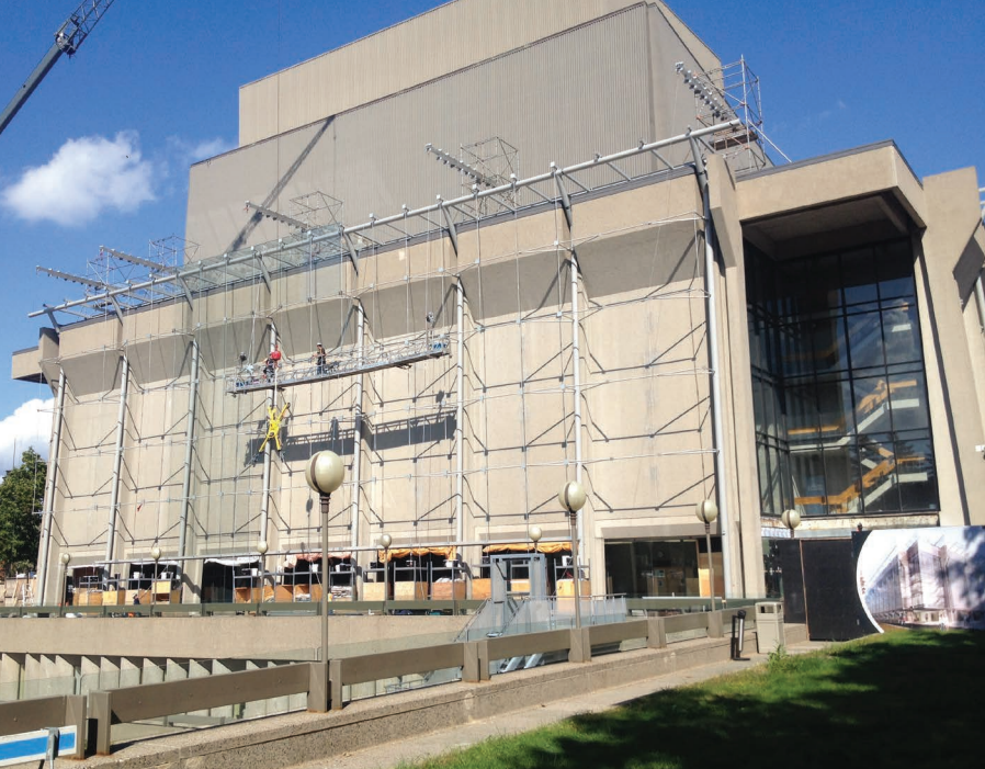
Installation du verre
