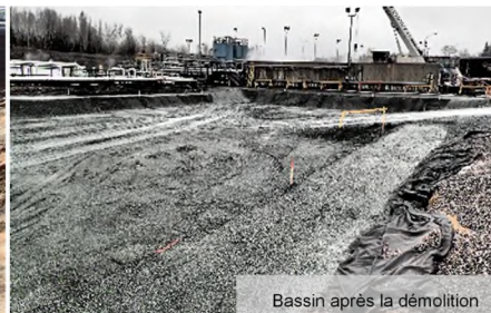
Bassin après la démolition
