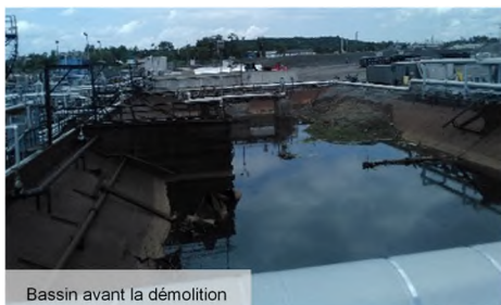
Bassin avant la démolition
