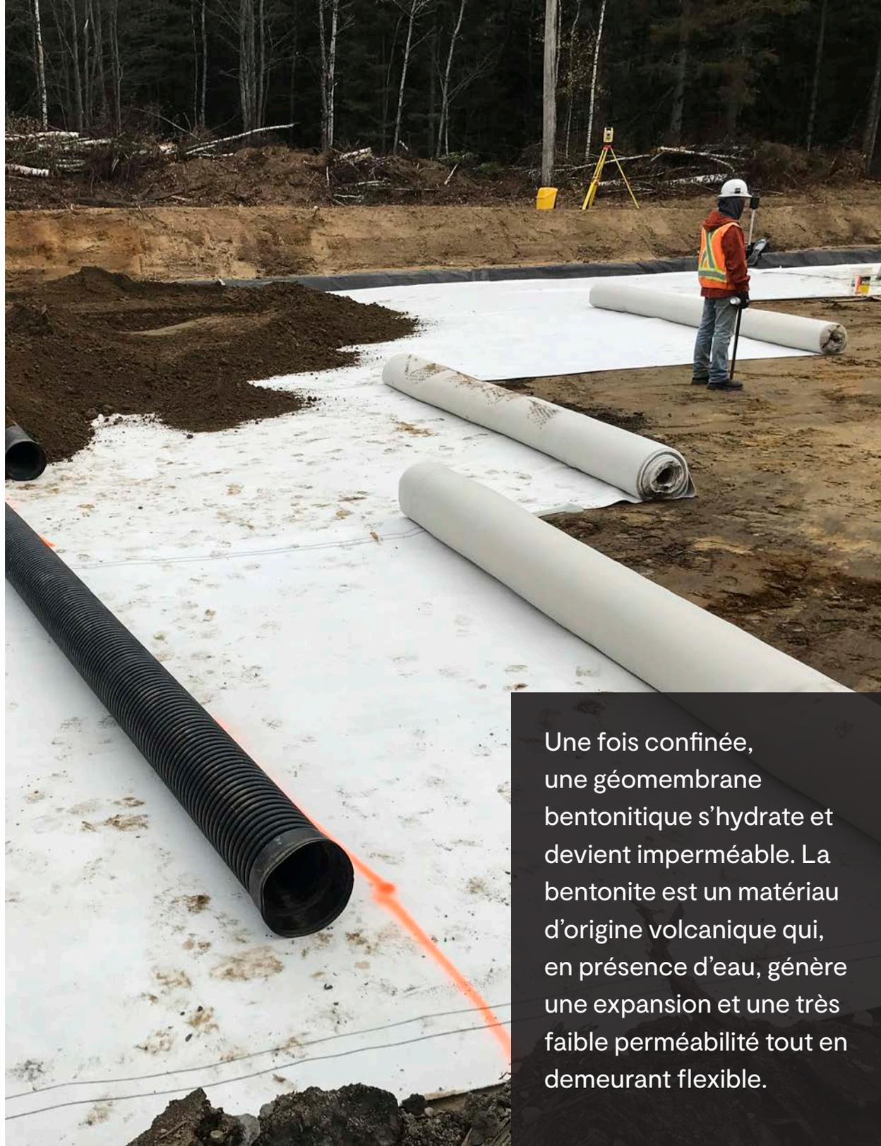
Une fois confinée, une géomembrane bentonitique s'hydrate et devient imperméable. La bentonite est un matériau d'origine volcanique qui, en présence d'eau, génère une expansion et une très faible perméabilité tout en demeurant flexible.
