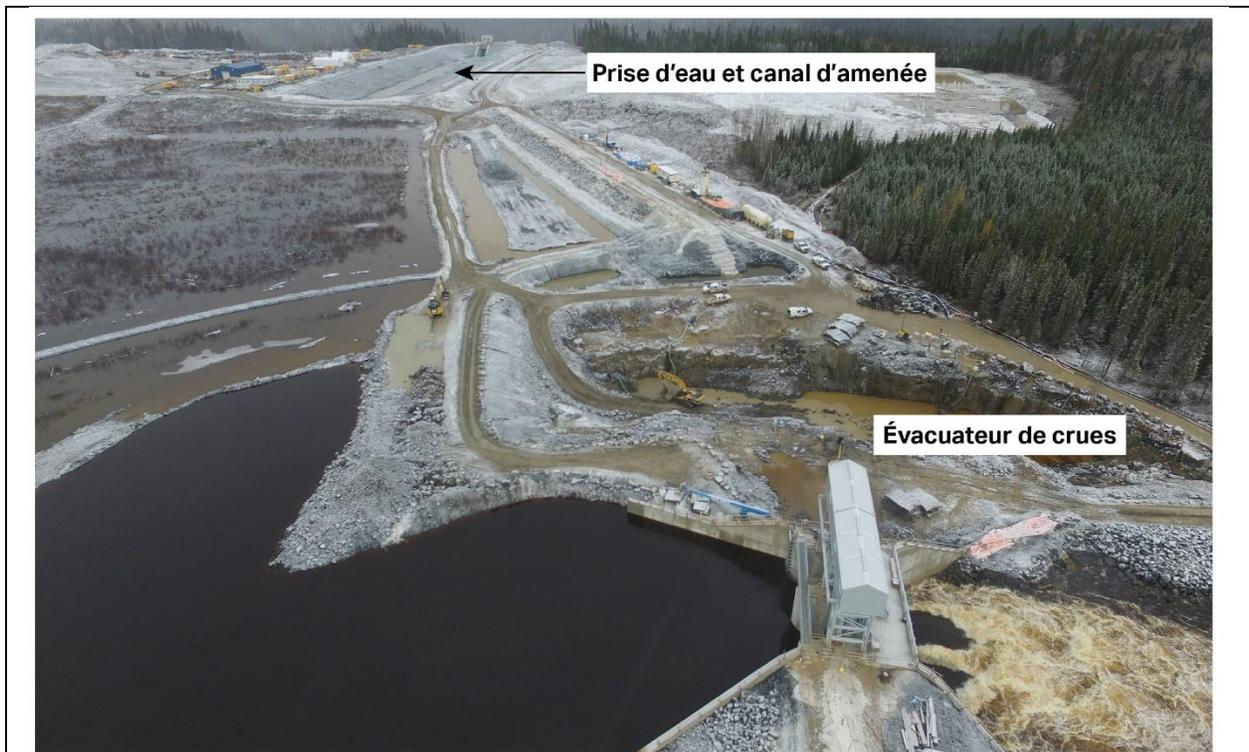
Figure 5 : Canal d'amenée, barrage gauche, évacuateur
