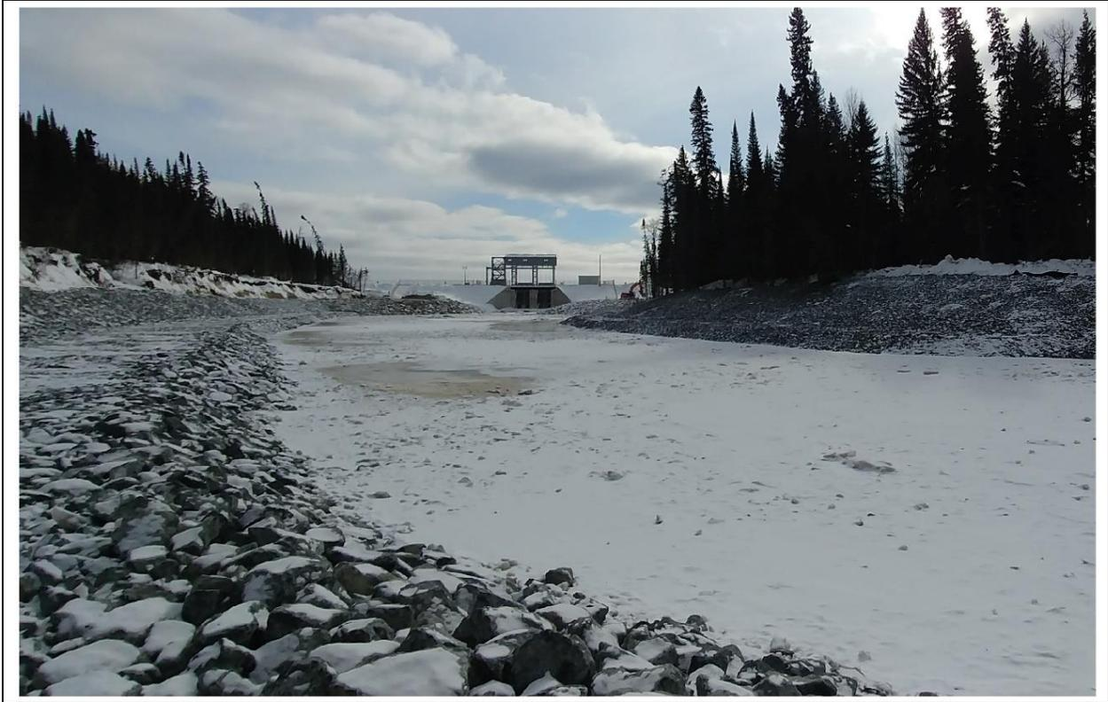
*Figure 9 : Protection en enrochement en aval de l'évacuateur*
