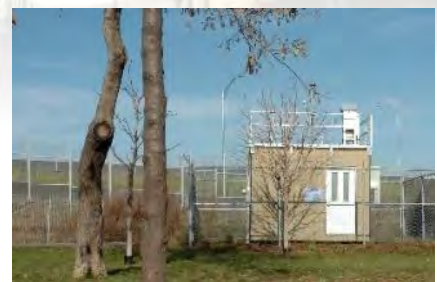
Station de la qualité de l'air (© MTQ, photo : Édith Martin)
